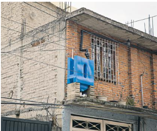
Överallt i stadsdelen Talpan i södra Mexico City syns organisationen Isla Urbanas blå vattenreningsystem, som hjälper invånarna att ta vara på regnvatten.
